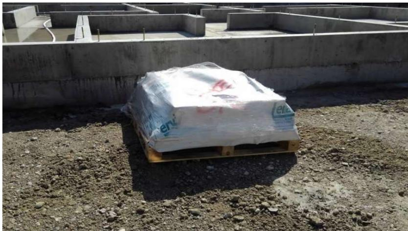
断熱材は風で飛ばないようにラップ養生
